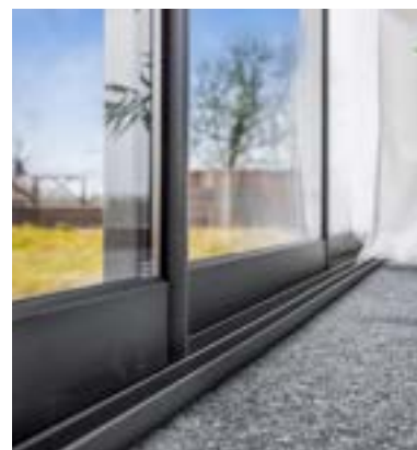
Sidoprofiler med rundad design. Hakar i varandra vilket ger ökad stabilitet och täthet.
